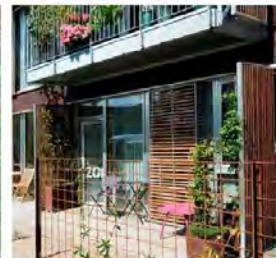
Espalier og trælameller kan skabe øget privathed mellem terrasser og altaner samt gode vilkår for klatreplanter Kilde: Almen Bolig 4, AI Arkitekter
