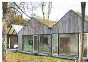
Grå træbeklædning, hvor træets struktur og naturlige gråimpregnering er synlig. Kilde: ONV arkitekter - Langesø
