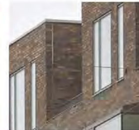
Delvist massive værn med forlængelse af facademateriale (kombination af murværk og lette balustre) Kilde: Østerbrogade, CF Møller
