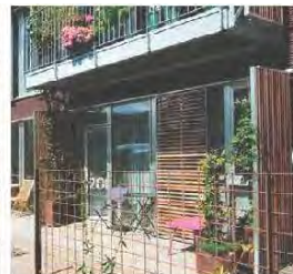
Skærmende espalier og trælameller ved terrasser som danner nicher og privathed. Udføres i træ, hvor træets struktur og naturlige farve er synlig. Kilde: Almen Bolig 4, Al Arkitekter
