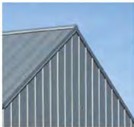
Lysegråt ståltag og facade Kilde: DS Stål
