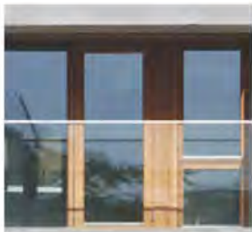
Vinduesrammer i træ/træ eller alternativt træ/alu i en lysbrun nuance Kilde: Bryggens Bastion, Arkitema
