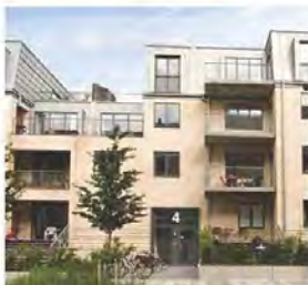
Altaner kan med fordel placeres i nicher og hjørner eller være delvist indeliggende Kilde: Flintholm Have, Arkitema
