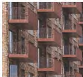
Altaner med lodrette balustre i brunrødt stål Kilde: Amaryllis Hus, Mangor & Nagel
