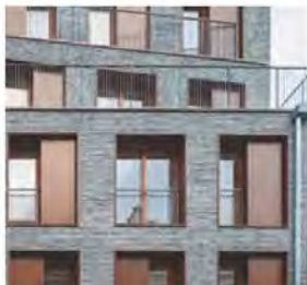
Vinduer og døre i brunrød aluminium Kilde: Orfila, Mobile Architectural Office
