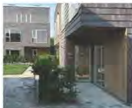
Ophængt tegl i mørkebrune eller sortbrune nuancer med træ i indhak, hvor træets struktur og naturlige gyldenbrune farve er synlig. Kilde: ONV Arkitekter
