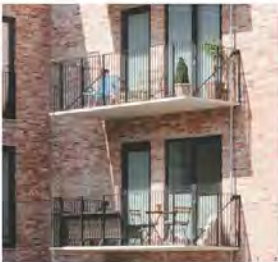
Altaner med lodrette balustre i sort eller gråt stål Kilde: Islands Brygge Parcel B, Henning Larsen
