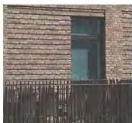
Relief i murværk i stueetagen danner skyggeeffekter og små variationer i øjenhøjde. Kilde: Amaryllis Hus, Mangor & Nagel
