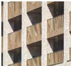
Altaner med lodrette balustre i lysbrunt stål Kilde: Ruskin Square, Allford Hall Monaghan Morris
