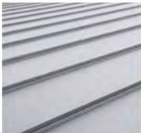
Lysegråt ståltag og facade Kilde: DS Stål
