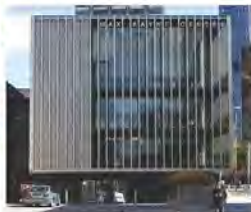
Lodrette lameller i metal eller tegl, træfarvede, gulbrune eller jordfarvede nuancer. Kilde: Haworth Tompkins
