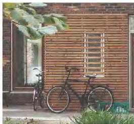
Vægpanel som lameller udført i træ, hvor træets struktur og naturlig gyldenbrune farve er synlig. Kilde: Arkitema
