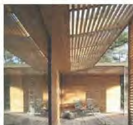
Udhæng som lameller udført i træ, hvor træets struktur og naturlige gyldenbrun farve er synlig. Kilde: Bergman - Werntoft House
