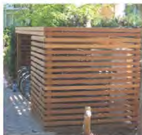
Overdækket cykelparkering og andre sekundære bygninger kan afskærmes med semi-åbne træfacader Kilde: Fremtidens Gårdhave, Niels Lutzen
