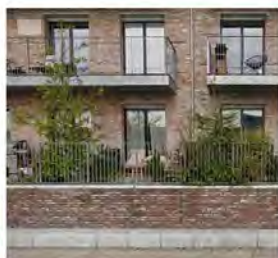
Terrasser hæves mod Læhegnet Nord Syd for at sikre privatliv og begrænse indbliksgener. Kilde: Flintholm Have, Arkitema
