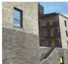
Genbrugstegl f.eks. patineret med kalkvand og sort pigmentfarve. Kilde: Henning Larsen
