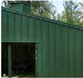
Stålplade med klikfals i en grøn nuance (Klyngehusene nord) Kilde: DS Stålprofil
