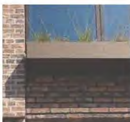
Plantekasser i stål, i farve der matcher husets øvrige malet stålfacader og altaner. F.eks. grønne, lysbrune eller brunrøde nuancer. Kilde: Amaryllis Hus, Mangor & Nagel
